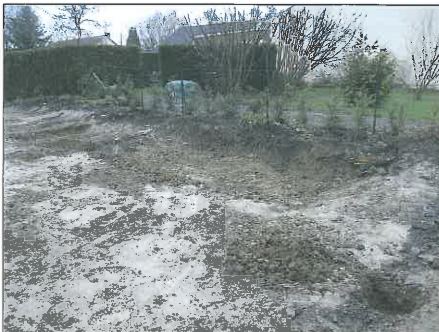
Figure 3 : Décapage de la parcelle - approfondissement jusque 40 cm (photo de novembre 2012)
