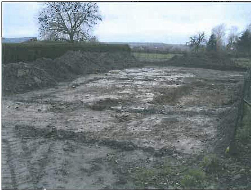
Figure 2 : Décapage de la parcelle (photo de novembre 2012)
